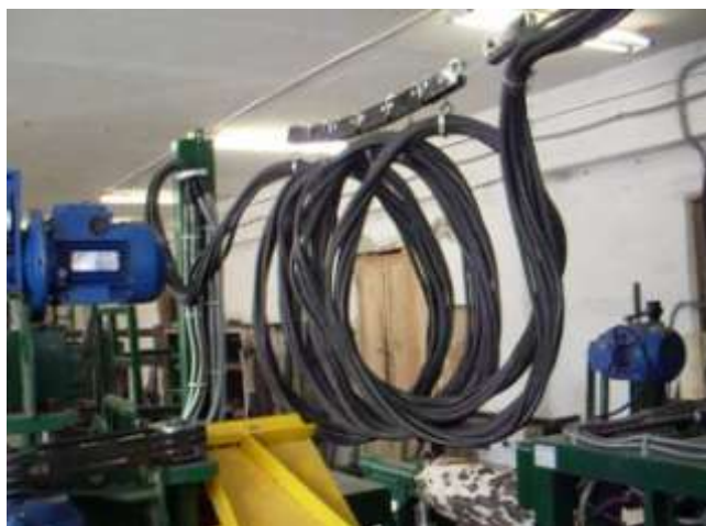
Рисунок 3. Установка подвески кабеля
